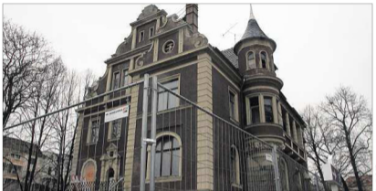
Attraktiver Standort: Die Villa in der Berliner Straße neben dem Novotel Gera wird nach jahrelangem Leerstand jetzt von der Firma Mading Bau saniert.
